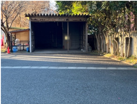
【1/29 改修前のガレージ】
