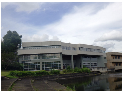
1 A棟複層ガラス（二重）窓の設置
