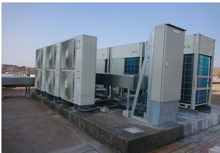
共同研究棟Cに個別方式空調機の設置
