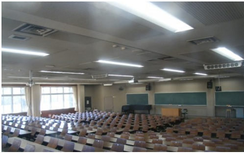
1 H棟照明改修によるLED照明の設置
