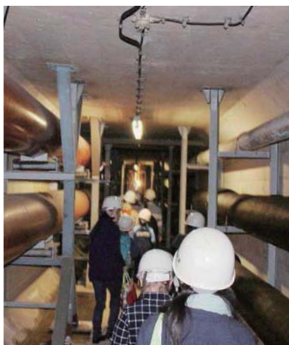
巨大な地下空間を探検した筑波大学地底探検ツアー
