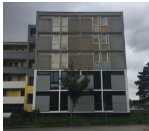
図 2 低層部が改修された住棟
