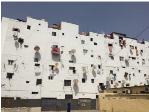
図 1 住民によって新たに壁が作られた住棟
