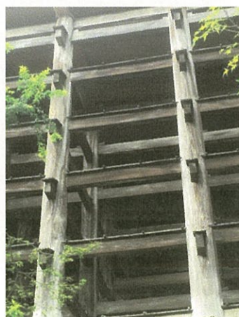
清水の舞台の柱と横梁が つながっているところ
