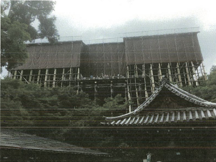
■改修工事中の清水寺
