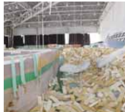
総合体育館 内部の状況
