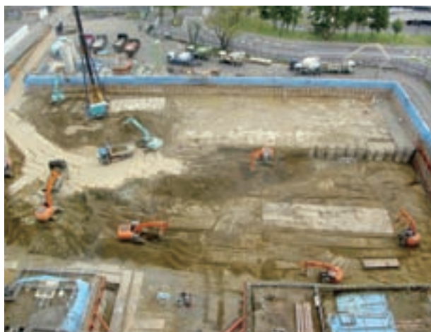
現在の工事の様子
