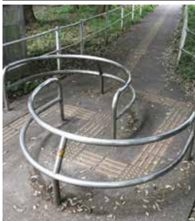
自転車侵入防止柵(6月1日) = 天野隼太撮影
