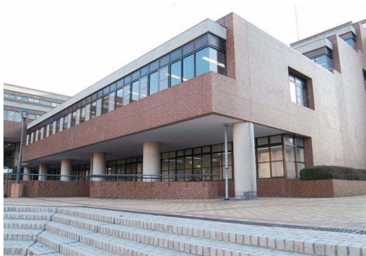
中央図書館改修工事
