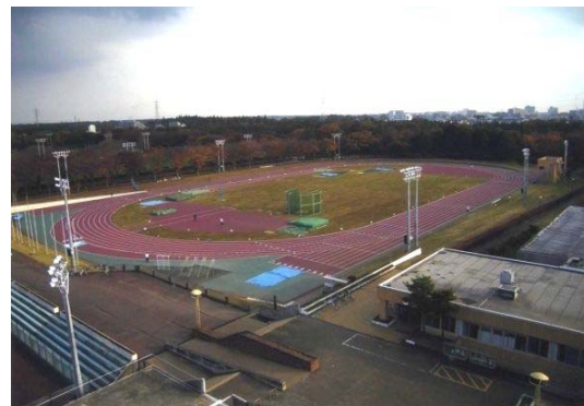
陸上競技場改修工事
