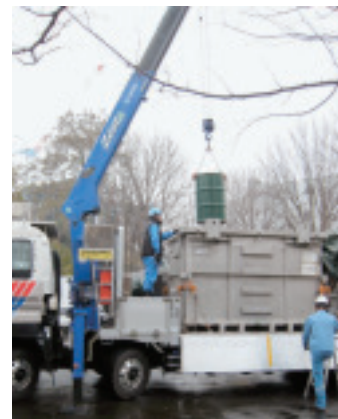
(B) 蛍光灯安定器搬出作業
