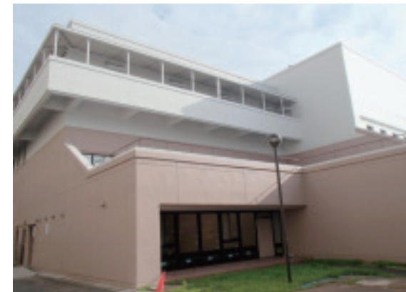
図書館・臨床講義室改修による複層ガラス(二重)窓の設置
