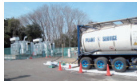
(A) 微量PCB廃棄物搬出作業
