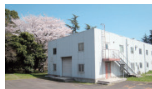
無機系廃液処理施設(鉄粉法処理設備)
