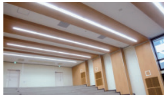
図書館・臨床講義室改修による LED 照明の設置
