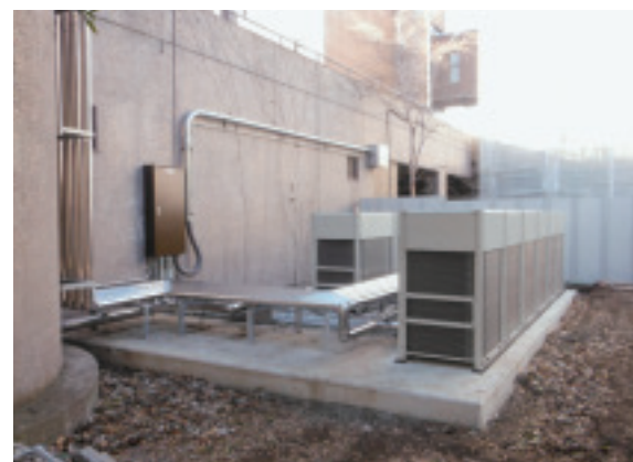
芸術学系工房棟に個別方式空調機の設置
